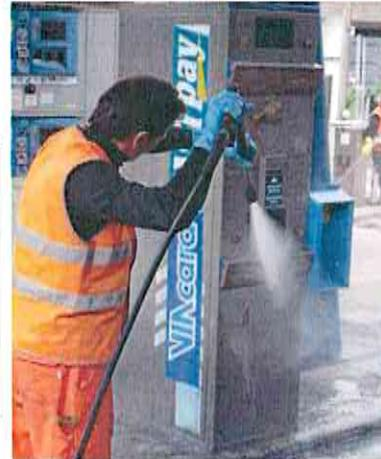
4 - lavaggio con idropulitrice a bassa pressione per la rimozione della soluzione acida
