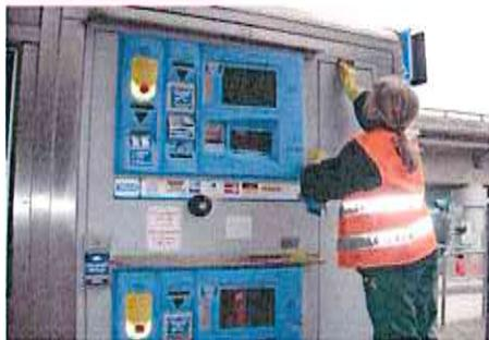
3 - pulizia con spugna tipo "scoch brite" su tutta la superficie trattata con acido. Rimozione adesivi e residui
